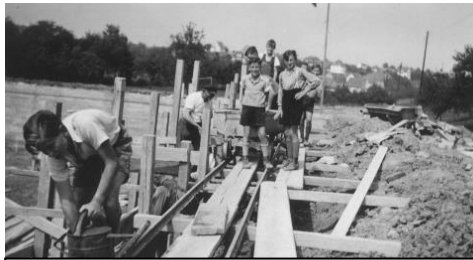
Schüler helfen beim Betonieren
